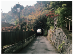
山の奥の住宅に通じる小さなトンネル。
